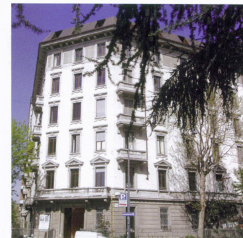
L'edificio di Piazza Mondadori, a Milano, ristrutturato da Lagare
