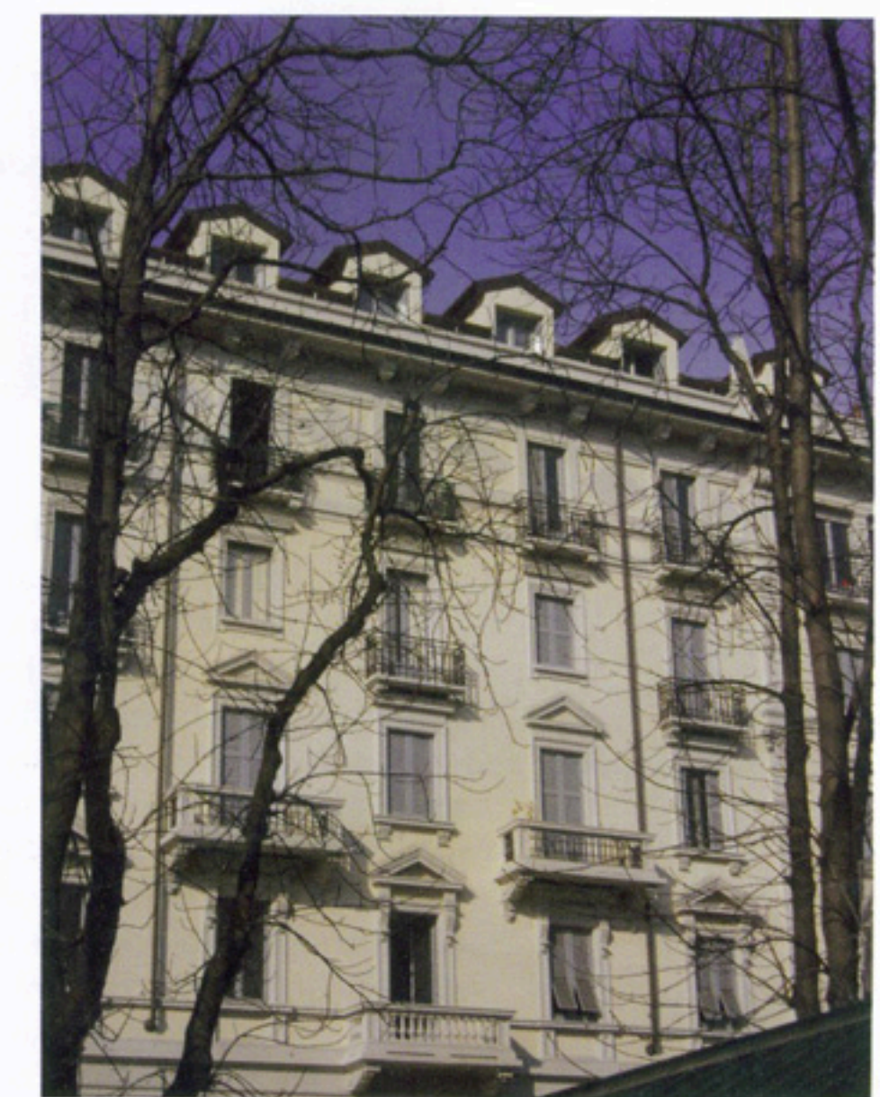
Lo stabile di Piazza Risorgimento, 7 a Milano
