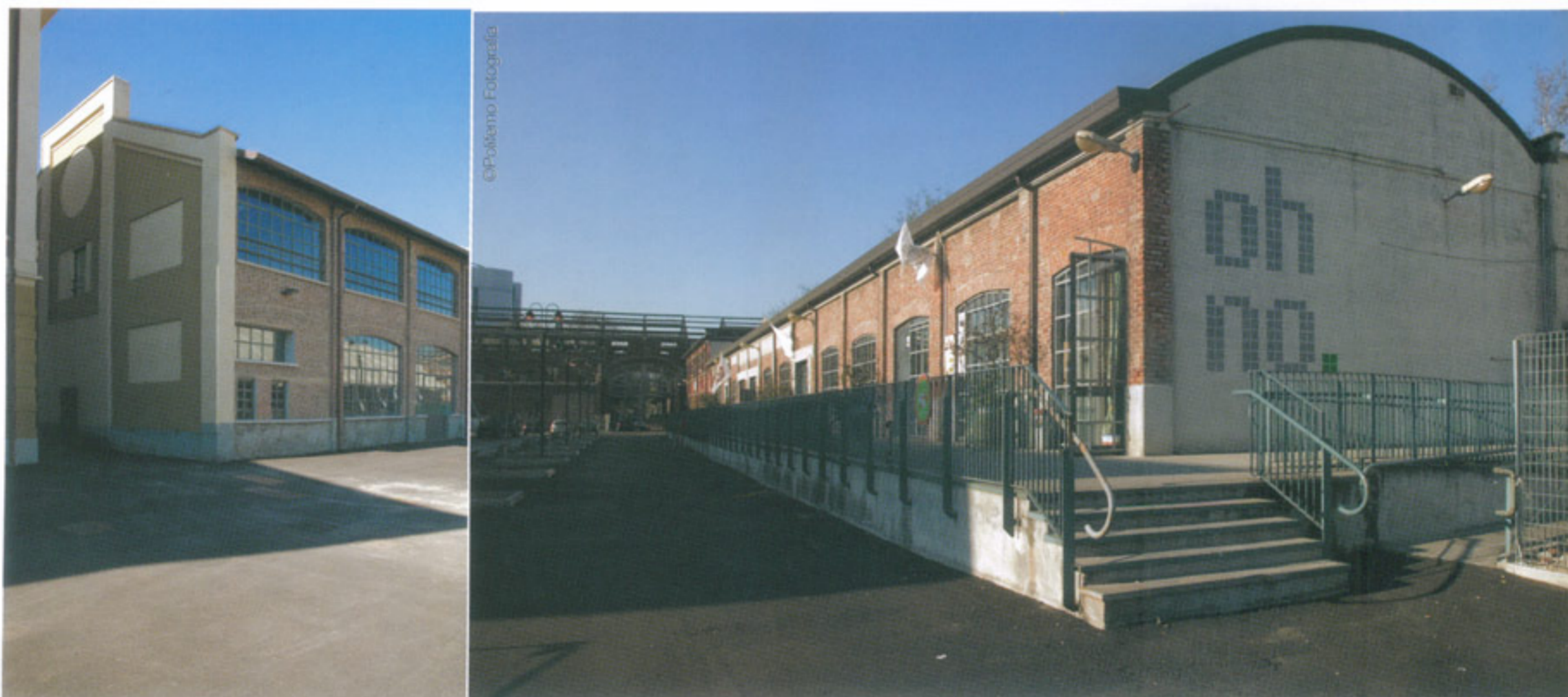
La Fabbrica del Vapore, un bel exemple d'architecture industrielle de la fin du XIX e siècle répartie sur 30 000 m 2 .
